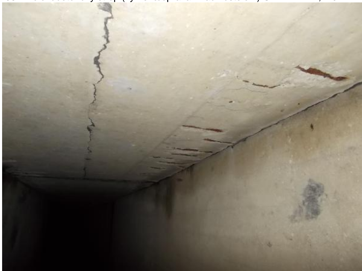
SO 08 – Železobetonový strop (výměna/oprava - nad kostelem) OPRAVA – 2,410km
