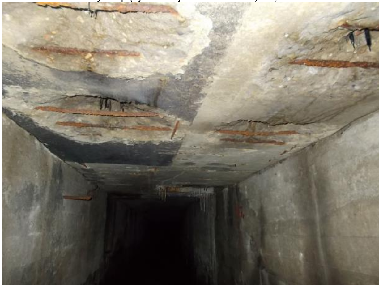
SO 05 – Železobetonový strop (výměna – jižní část náměstí) – 1,470km
