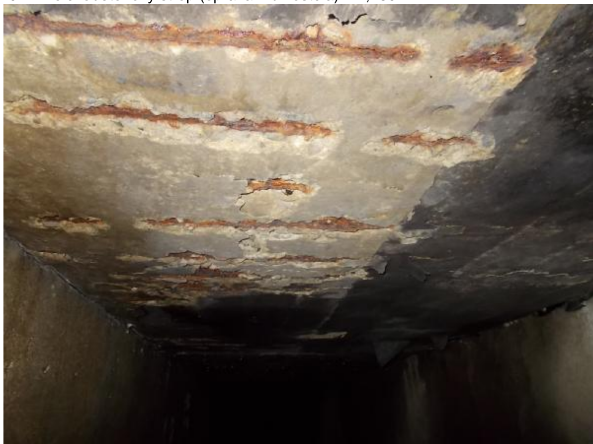
SO 07 – Železobetonový strop (oprava – u kostela) – 2,160km
