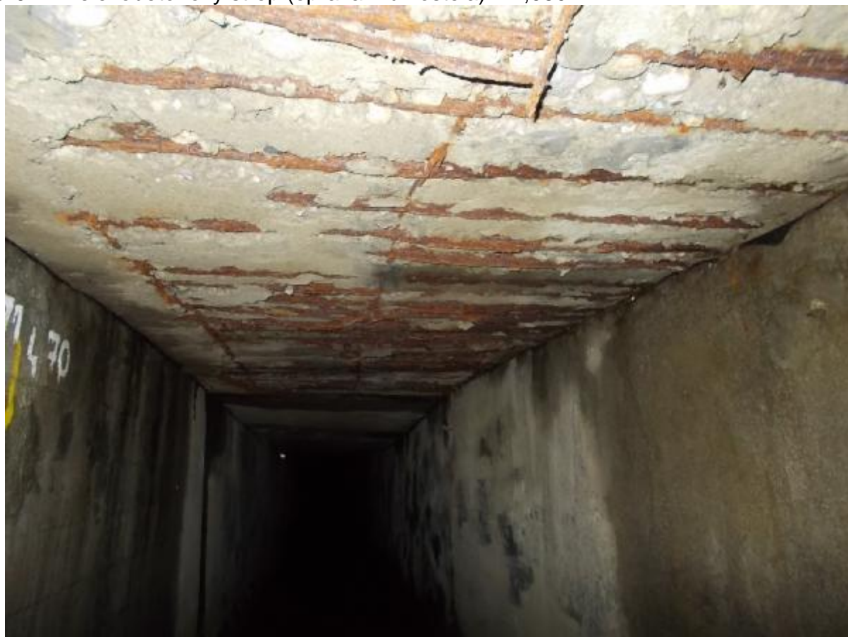
SO 07 – Železobetonový strop (oprava – u kostela) – 2,060km
