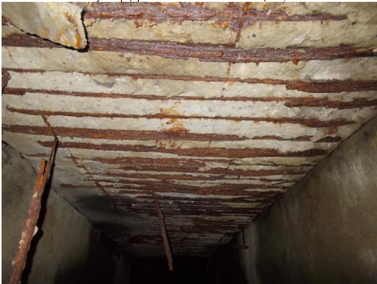
SO 06 – Železobetonový strop (oprava – severní část náměstí) – 2,000km
