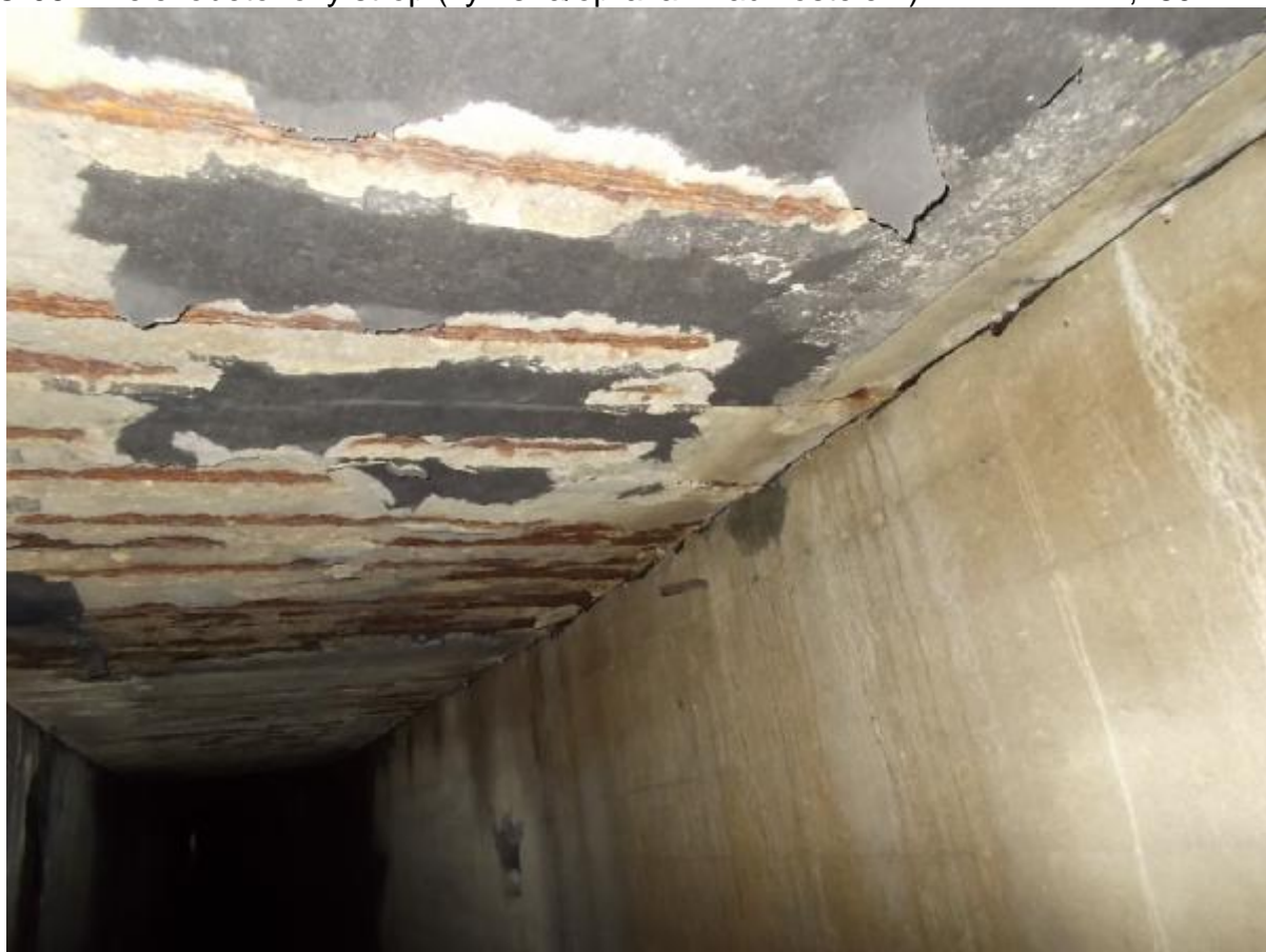
SO 08 – Železobetonový strop (výměna/oprava - nad kostelem) VÝMĚNA – 2,280km
