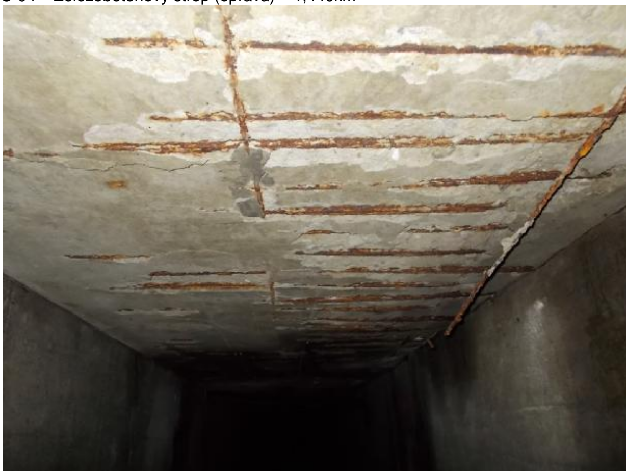
SO 04 – Železobetonový strop (oprava) – 1,440km
