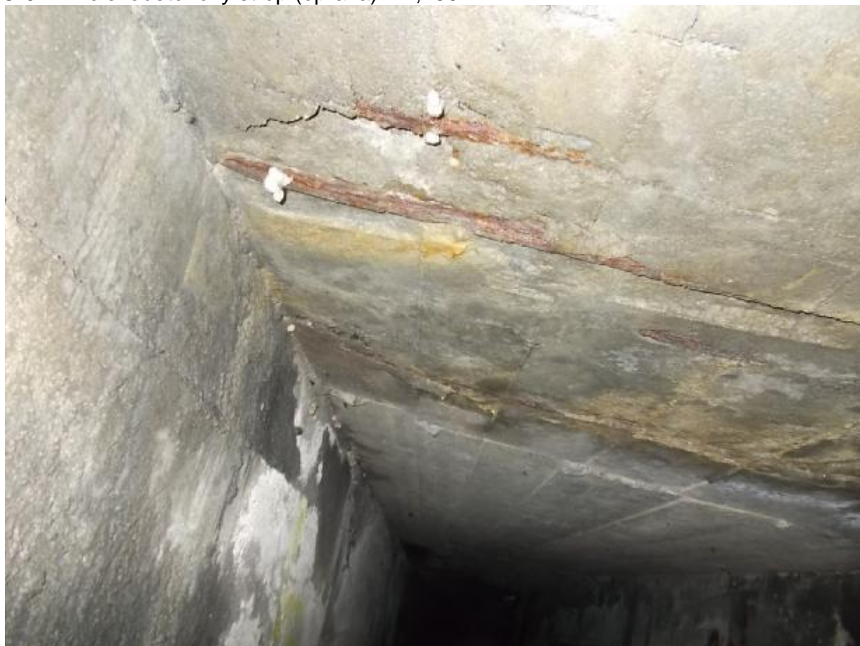
SO 04 – Železobetonový strop (oprava) – 1,250km
